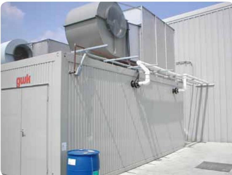
gwk-Kühltürme dienen zur Abfuhr von Überschusswärme aus Produktionsanlagen mit höherem Temperaturniveau und arbeiten nach dem Verdunstungsprinzip. Kühltürme sind Bestandteil der schlüsselfertig gelieferten zentralen Kühlturmanlage, die mit einer frei programmierbaren Mikroprozessorsteuerung geregelt wird.
