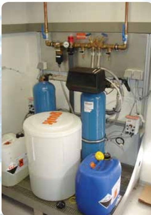
*Doppelenthärtungsanlage zur Entfernung der kesselsteinbildenden Minerale und Dosierstation für korrosionshemmende Inhibitoren, integriert in eine Container-Kühlanlage*
