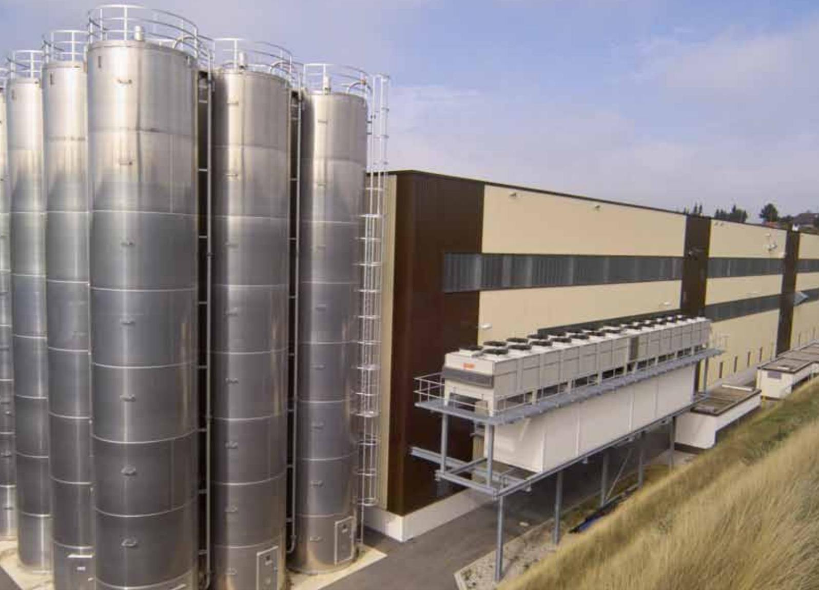
Alle Container zur Aufnahme der Kühlanlagen sind Spezialanfertigungen, die den jeweiligen, spezifischen Ansprüchen und Anforderungen entsprechen. Die schall- und wärmeisolierten Wände sind mit Öffnungen zum Anschluss der Betriebsverrohrung und der Elektroversorgung versehen. Zur
